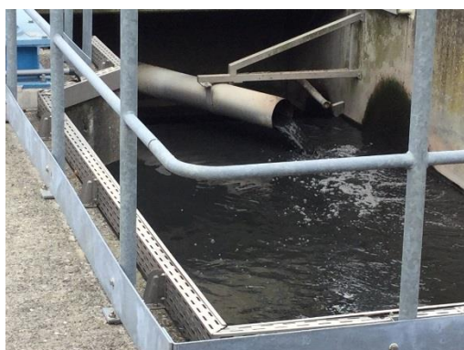
L'eau rejetée dans un bassin de transition.
