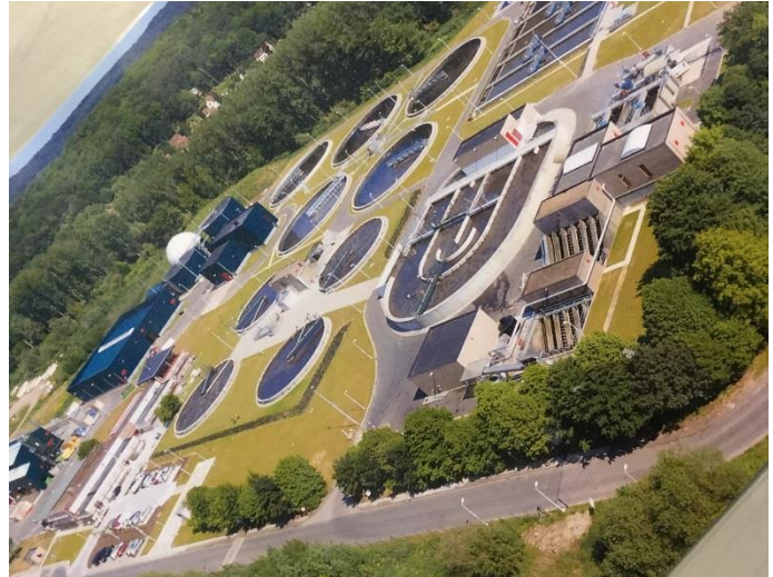
Station d'épuration de Wavre
