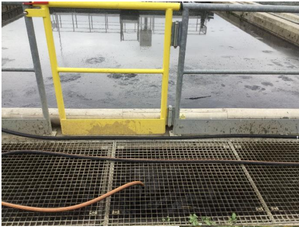
Le bassin de la décantation primaire
