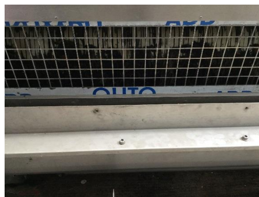
Le petit dégrillage
