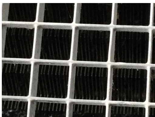
Le petit dégrillage
