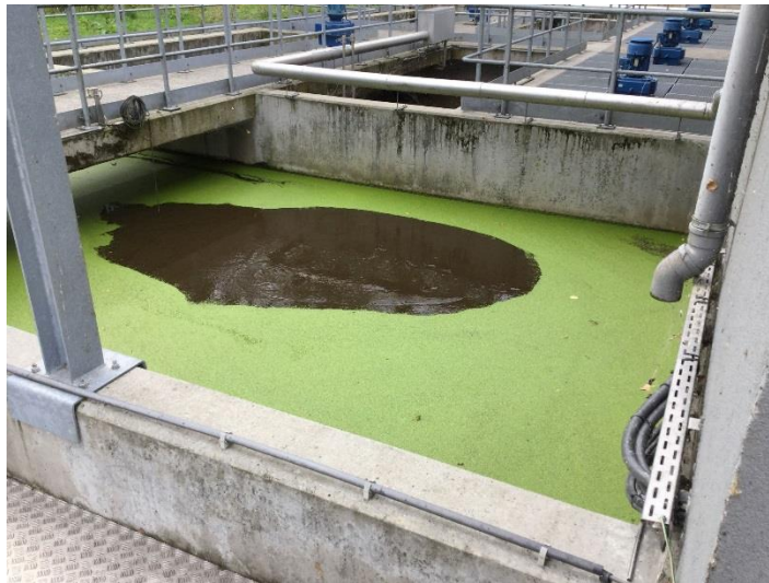
Le bassin du traitement chimique.
